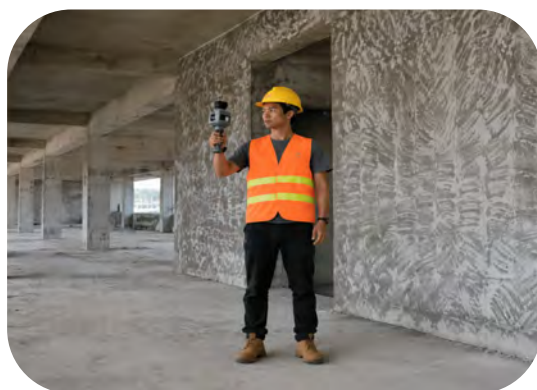
Inspección de edificios
